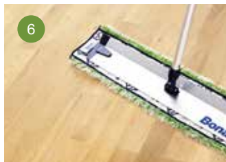
Enlever la poussière de ponçage avec un pad Bona ou l'aspirateur Bona DCS25.
