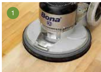
Poncez le sol avec Bona FlexiSand ou Bona Belt.
